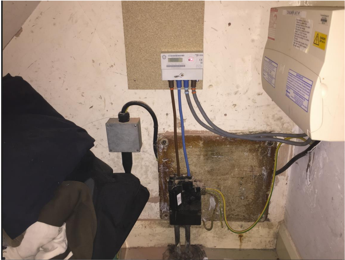
Asbestos wool fuse suppression
